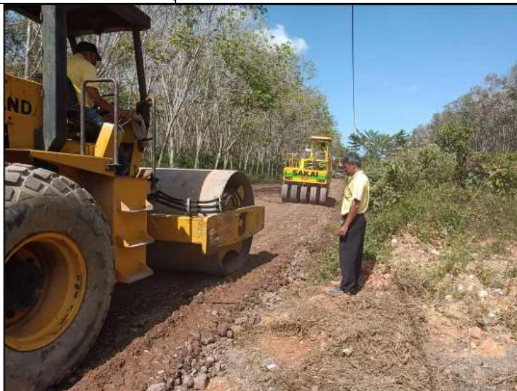
งานด้านโยธา ได้แก่ งานซ่อมแซมบำรุงรักษากถนน
